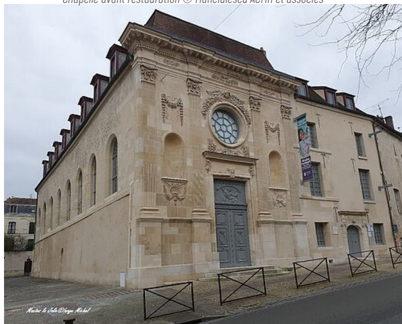
Chapelle après restauration © Mantes-la-Jolie © Michel POTREL
