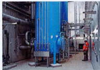
Une nouvelle unité de décarbonatation a été mise en service sur la commune de Vernouillet en 2022. Elle permet l'alimentation en eau adoucie de 27 000 habitants situés dans les communes de Chapet, Verneuil-sur-Seine et Vernouillet. Capacité de production : 400 m<sup>3</sup> / heure. Avec cette nouvelle installation, 271 000 habitants bénéficient de ce service dans 45 communes du territoire. Montant du projet : 4 956 398 €.
